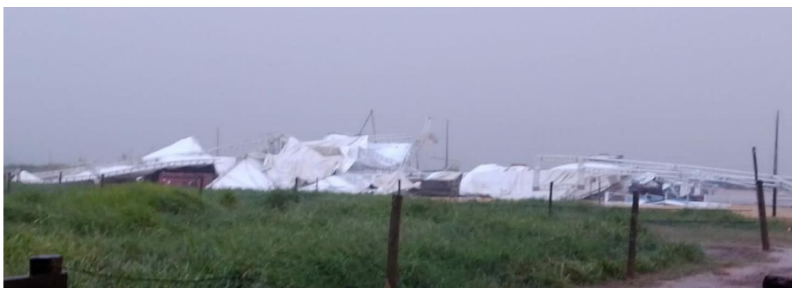
Local do evento após as fortes chuvas e ventania destruírem a estrutura
